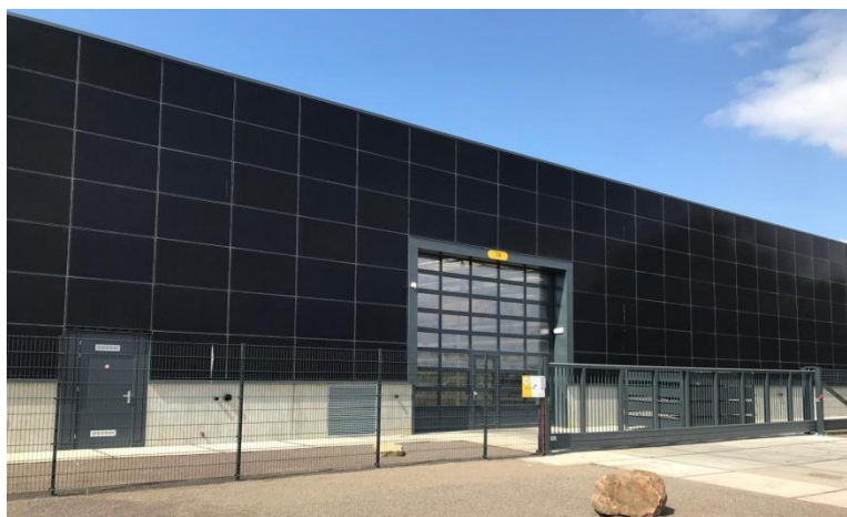
Gevel met zonnepanelen (foto: Ron Broeders)
